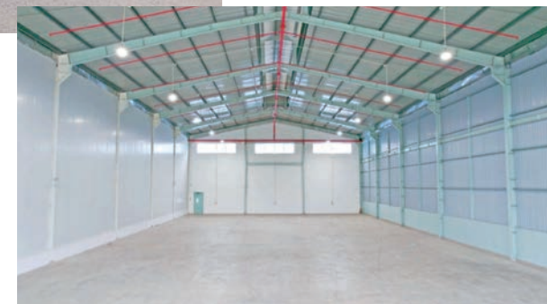
▲レンタル工場内部
