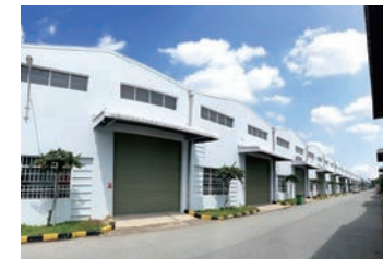
▲レンタル工場の外観
